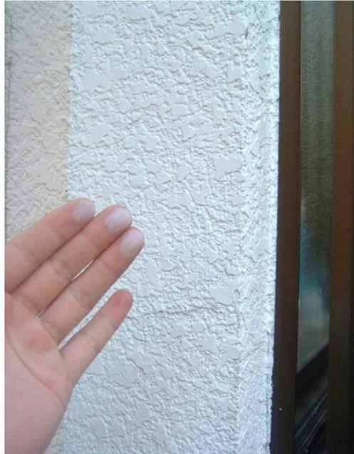
塗料の色に必要な「顔料」。その顔料が塗料の樹脂とともに経年劣化により表面に浮き出てくる物です。
