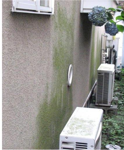
風通しの良くない面(北側)、乾きづらい面、場所などに生えます。付着した汚れが落ち切らずに外壁に残り、そこから発生します。
