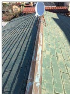
これはコロニアル屋根の端を押さえている物で、この水切り金物の下にある木材に釘で止めてあります。ほとんどの場合、この水切り金物は鉄製で長年の放置状態により、写真でもわかる通り、サビてきてしまいます。
