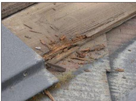
このような場合は、水切り金物とこの木をそっくり交換します。（この木の部分は、10年くらい前までは木製でしたが、最近では樹脂製のものが主流となっています。）交換した上で、水切り金物を再度取り付けます。
