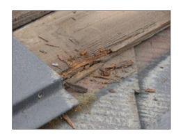
このような場合は、水切り金物とこの木をそっくり交換します。(この木の部分は、10年くらい前までは木製でしたが、最近では樹脂製のものが主流となっています。)交換した上で、水切り金物を再度取り付けます。
