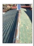
これはコロニアル屋根を押さえている物で、この水切り金物の下にある木材に釘で止めてあります。ほとんどの場合、この水切り金物は鉄製で長年の放置状態により、写真でもわかる通
