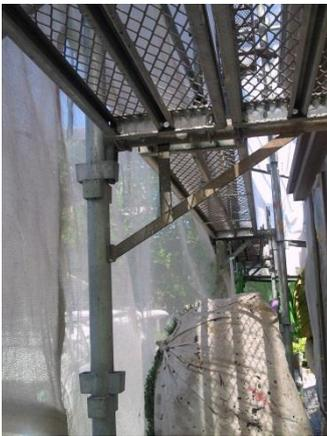
組み立てていく際には、垂直に立てたパイプとパイプの間に、地面と水平になるよう横にパイプを差し込み繋げていきます。
