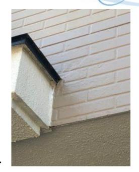
補修前 (剥がれてきた塗膜を除去後) → 補修後
