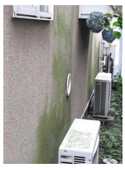
風通しの良くない面(北側)、乾きづらい面、場所などに生えます。付着した 汚れが落ち切らずに外壁に残り、そこから発生します。
