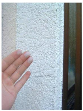
塗料の色に必要不可欠な「顔料」。その顔料が塗料の樹脂ともに経年劣化により表面に浮き出てくる物です。
