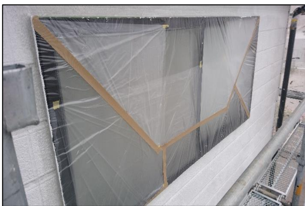
↑養生中の窓（写真は外壁下塗り完了時）
