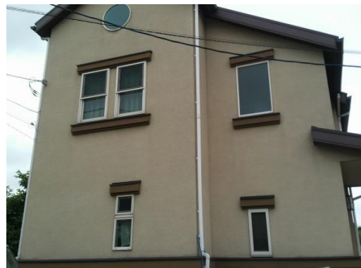
(↑モルタル外壁リシン吹き付け仕上げ)
